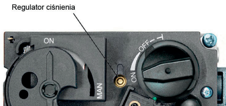
Rys. 13. Sposób regulacji ciśnienia wylotowego
